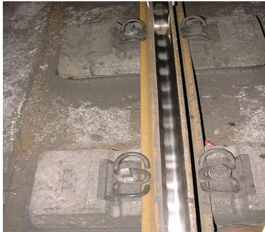
**Figure 4 : Usure ondulatoire sur une section de rail.**
