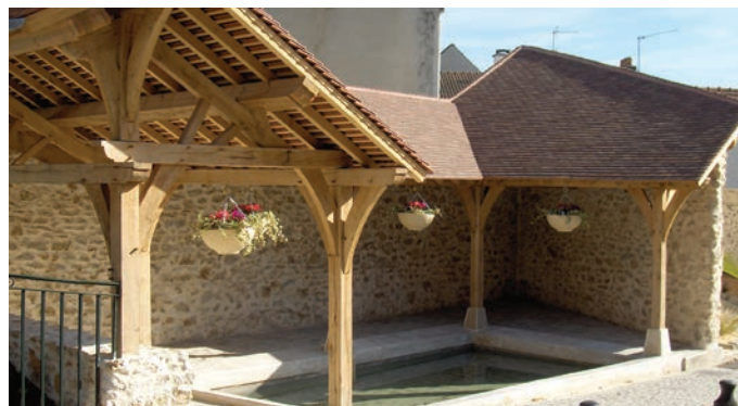
→ Champlan / Nouvelles circulations douces (chemin du Lavoir...), aides à la rénovation du complexe sportif et à la réfection de la rue de la Division Leclerc.
