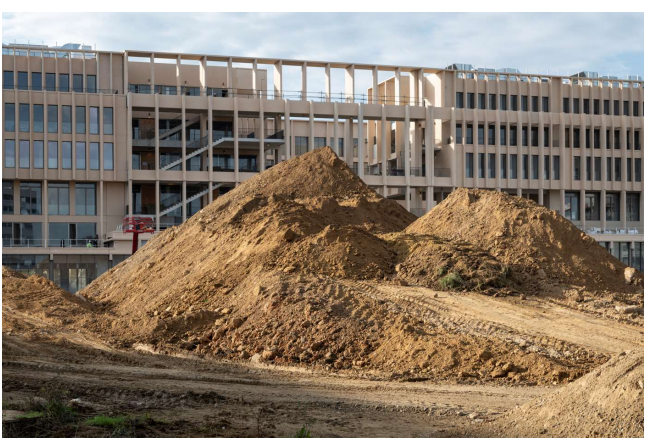
Réutilisation des terres sur site
