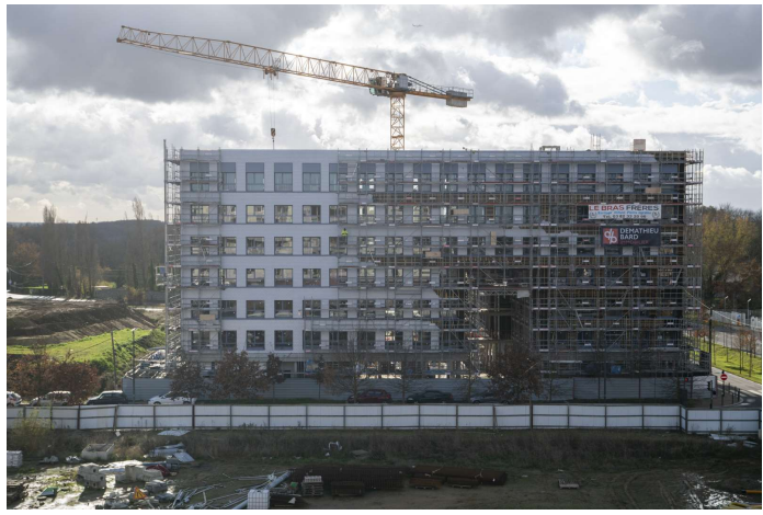
Construction bois et bioclimatique
